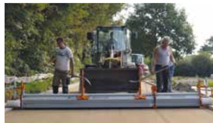
Höhenverstellbare Laufwerke im Einsatz über Bordsteinkante u. Niveau-Schienen
